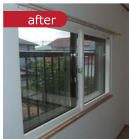
↑開口部断熱で省エネ対策を新設
