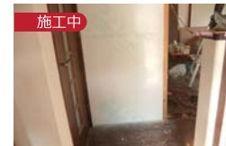
面材による壁補強の様子。
