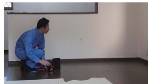
専門の機器を用いて建物の傾きを調査します。
