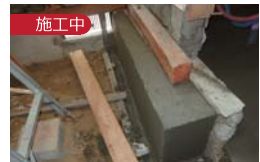
基礎補強の様子。
