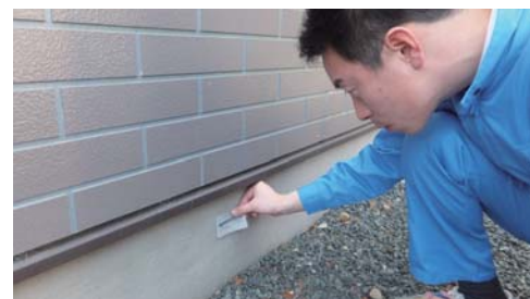
基礎の高さやひび割れの有無を確認します。
