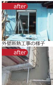
基礎の増し打ち補強
