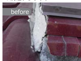
外壁の欠損。
